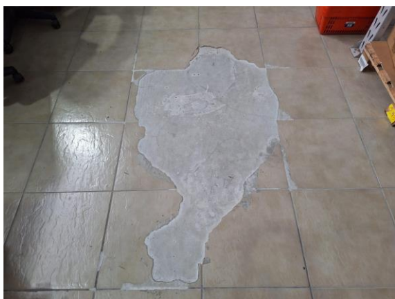
11 Condição do piso cerâmico
