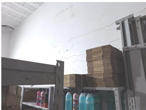
5 Vista interna: fissuras na parede nordeste
