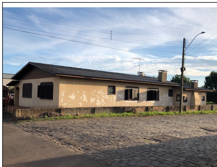
Figura 1: Imóvel sito à Avenida Militar, nº 2202, Bairro Jardim América.
