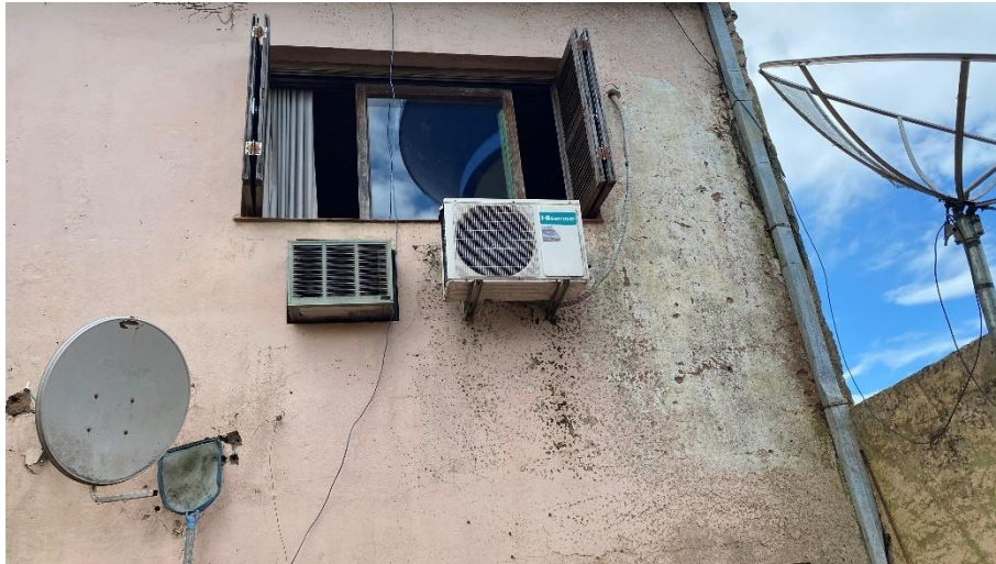
Detalhe fachada Norte
