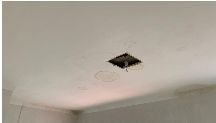
Detalhe forro Sala 2
