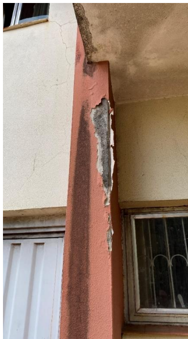
Detalhe fachada Sul
