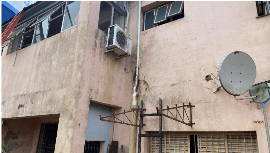
Detalhe fachada Norte
