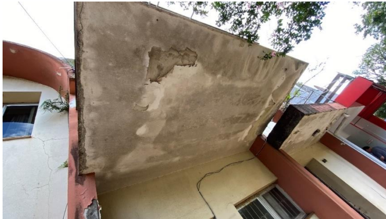
Detalhe sacadas Sul
