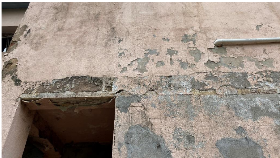
Detalhe fachada Norte
