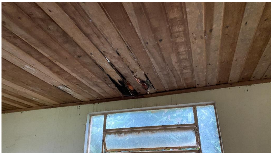
Detalhe forro Sala 1 andar superior
