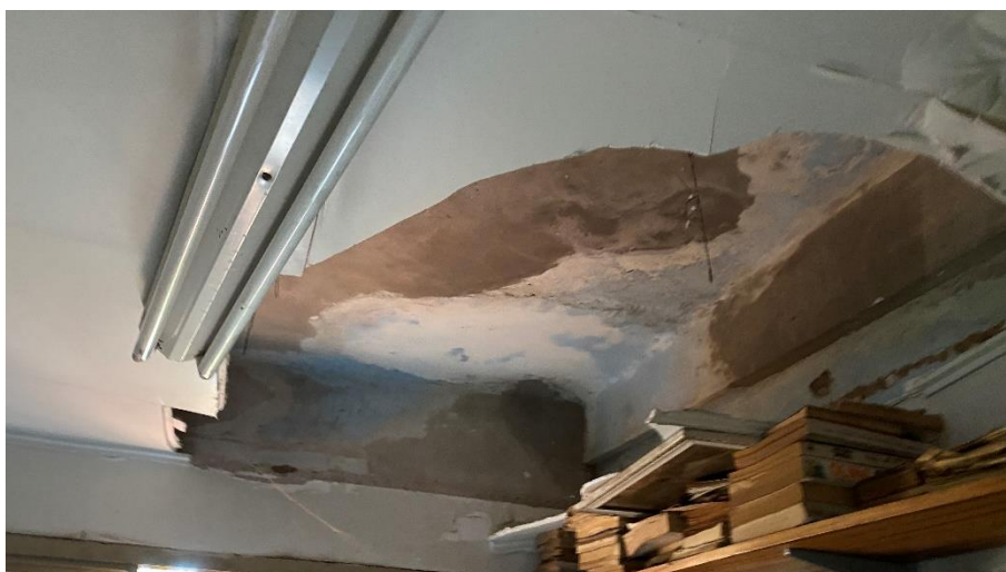
Detalhe forro Depósito
