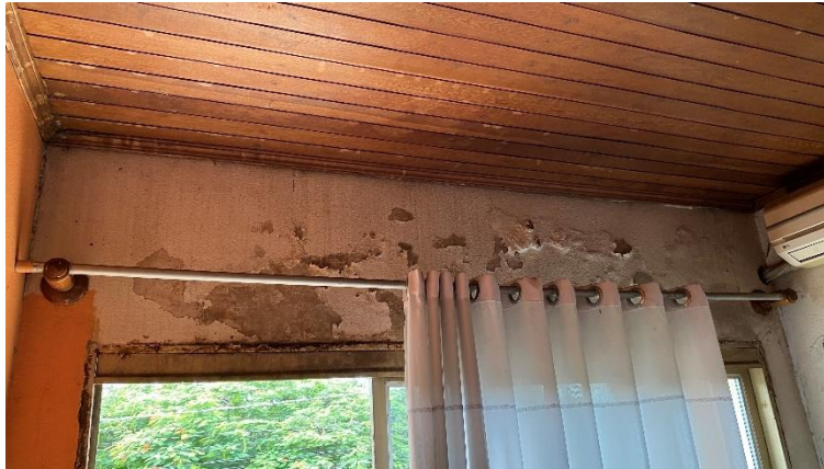
Detalhe parede Sala
