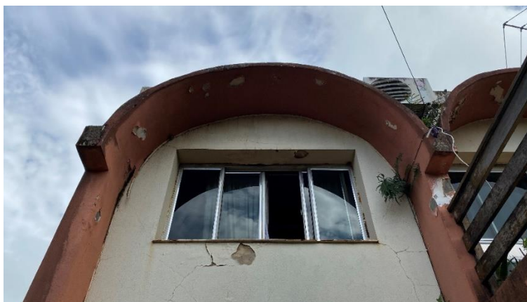
Detalhe fachada Sul
