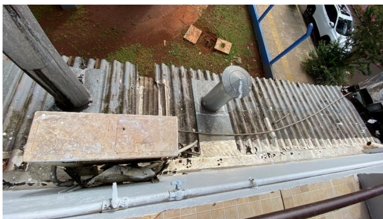
Detalhes telhado Cozinha do Bar - lado Leste
