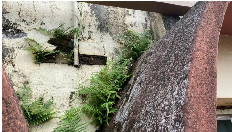
Detalhe fachada Sul
