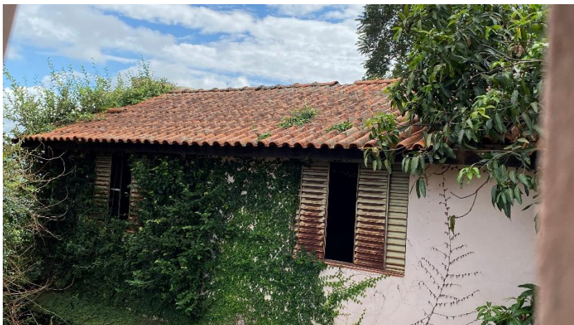
Vista do telhado
