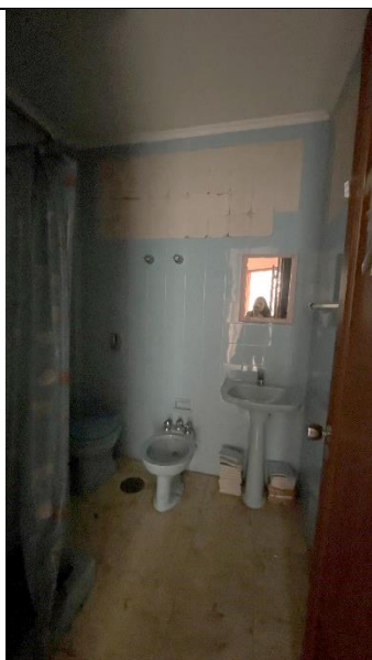
BANHEIRO DORMITÓRIO DE EMPREGADA COM FALHA NO REVESTIMENTO DE AZULEJO
